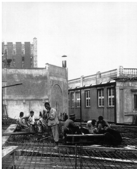
大光明电影院工地上的建筑工人。
