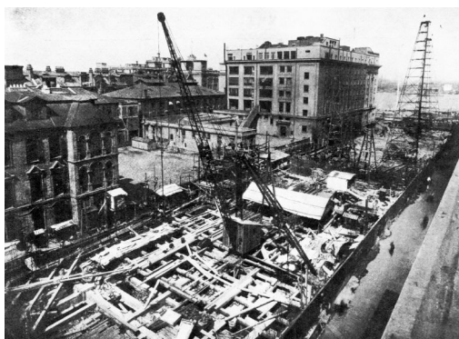
附近全是高楼，地基施工采用50米深桩，钢板围护，不妨碍周边建筑安全。
