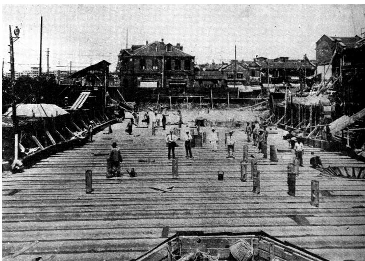
大厦现场安装了搅拌机，浇注混凝土。
