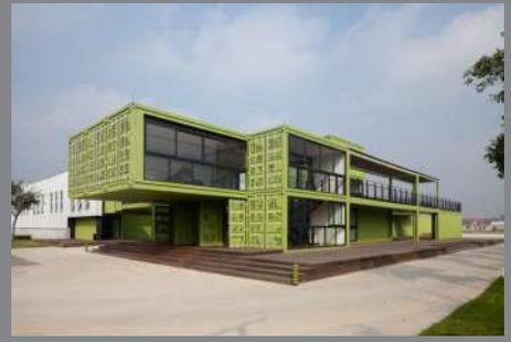
中国是集装箱生产第一大国，生产能力已经达到每年580万TEU（国际标准箱单位，以20英尺箱体容积为计量单位），全世界96%以上的新造集装箱由我国生产。同时，我国也是集装箱淘汰大国，累计有约120万个集装箱在中国被淘汰出货运业，并且每年在国内淘汰出货运业的集装箱多达30万个。如果将其全部改造加以利用，那么每年可以建造出近450万平方米建筑面积的集装箱建筑物。由于集装箱大修成本很高，一般正常工作10年之后就会出现结构及围护钢板锈蚀强度降低的问题，不适合再作为运输集装箱使用。对旧集装箱的处理方法一般为闲置在码头任由锈蚀或者将其回炉炼钢，这
