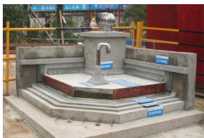
屋面工艺样板
