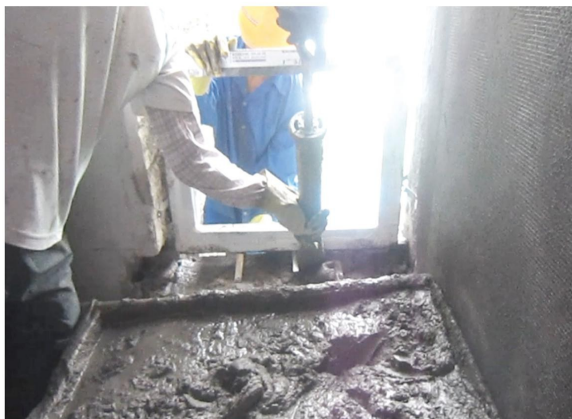
外墙塞缝专用注浆工具注浆工艺
