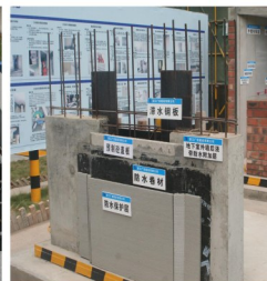
地下室剪力墙样板
