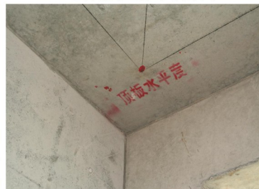
楼顶板水平度测量
