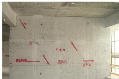
剪力墙平整度测量
