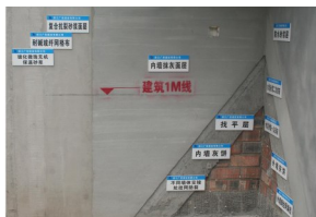
室内抹灰工艺样板
