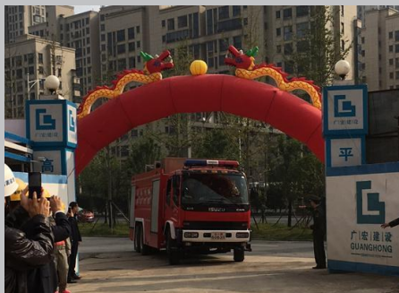
消防车辆进入施工现场
