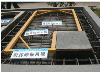
厨房钢筋绑扎及厚度控制样板
