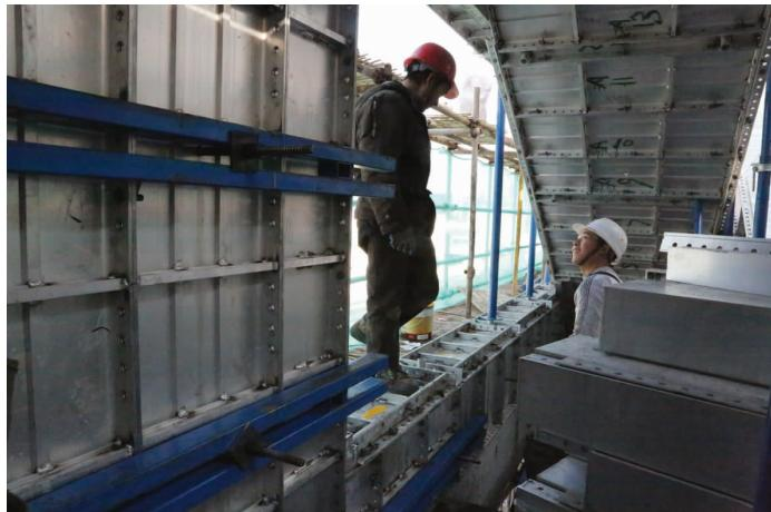
日前,远疆天域项目部铝模工正在紧张有序地进行铝模板的安装。这些铝模产品是由浙江建恒建筑科技有限公司提供的。此前,由公司承建的宁波美的蝴蝶海苑五期、长沙时代玫瑰园社区两个项目相继采用了铝模板,并取得良好效果。
