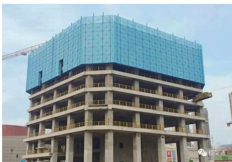
3、文明施工方面,铝模系统全部配件均可重复使用 150–300 次,一套模具、三套支撑架的固定搭配,让施工过程中不需用更改模具支模体系,可循环交替使用,让施工场地找不到多余的材料。随着楼层的升高,附着式升降脚手架同步上升,与铝模结合使用,无须更换结构,标准防护。
