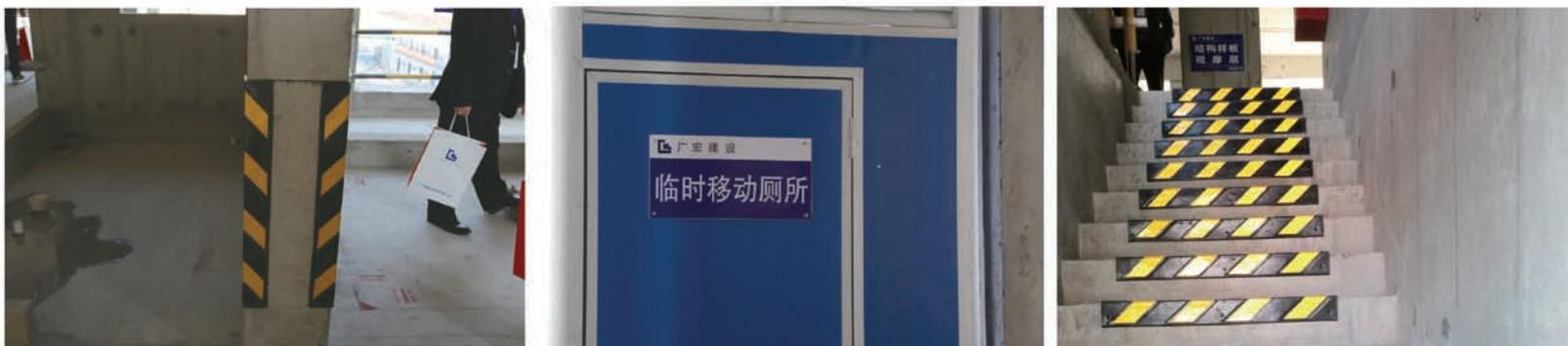
建筑楼层,设置临时厕所,在阶梯、墙体棱角处,安置成品保护设施
