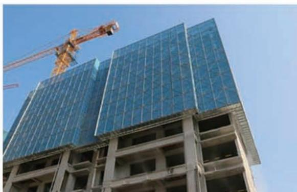
产品本身的全钢防火性能、智能控制等优势之外,主要体现在节材省工方面,现场管理更便捷。普通钢管脚手架用量较大,所有钢管的进出场运输、归类、人工、塔吊吊装、主体封顶后爬架拆除、塔吊也可提前拆除,节省租赁费用等。
