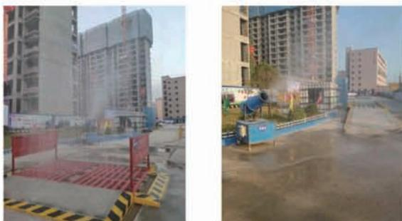
1. 本项目修筑了一条 6 米宽环形水泥硬化主道路,场地主入口设置自动洗车机,冲洗后方可进入场内主道,并在出入口和作业区设置雾炮降尘器。
