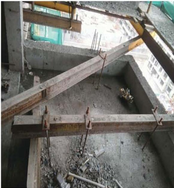
●扣件式钢管支模架按照与施工方案不符,扫地杆设置过高、剪刀撑未设置、立杆间距部分过宽等问题较多,标准层尽量使用承插式钢管支模体系。
