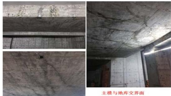
顶板裂缝集中地库与主楼交界面、裂缝大多发生在后浇带浇筑完成后
