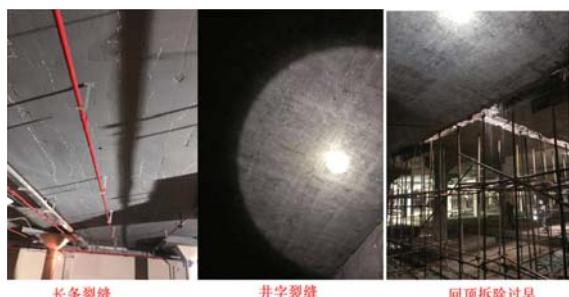
1、顶板裂缝,初步分析原因:雨天浇筑强度不达标,养护不到位,无回顶或局部荷载过大、过早
