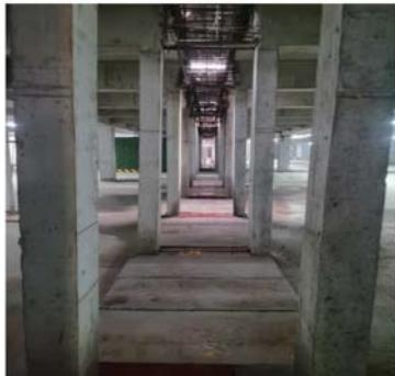
3.9.3、后浇带混凝土预制盖板
