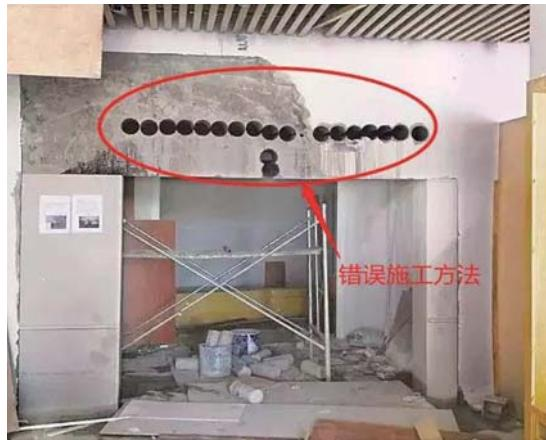
▼孔在梁下口(梁下口钢筋已断):
