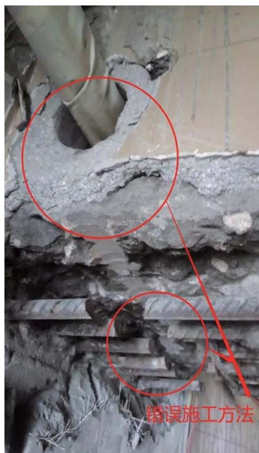
钢筋混凝土梁在受弯时,局部受压、局部受拉,混凝土承担压力,钢筋承担拉力,两者相互配合,缺一不可。那么如果在安装施工过程中打断主梁的纵筋,横梁承受的拉力就完全由混凝土来
