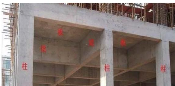
横梁：一般都是钢筋混凝土梁（以下简称梁），而梁中最主要的结构功能就体现在其中的钢筋中。
