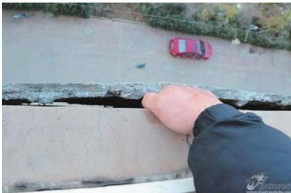
1)外围墙体变形与施工操作不当,引发保温层裂缝。保温层与饰面层由于温差、干缩变形导致抗裂层开裂。
