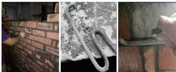
砌筑完后采用勾缝小工具进行勾缝
