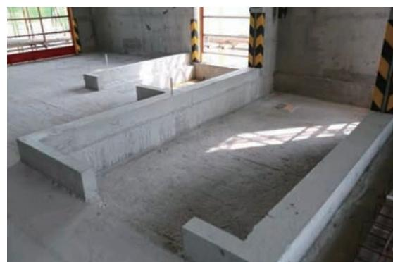
卫生间管井宜做高于本层楼地面150mm高C20细石混凝土翻边,防止管井根部渗漏水。
