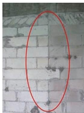
混水墙面组砌方法混乱,出现通缝和“二层皮”,组砌形式不当,形成竖缝宽窄不均
