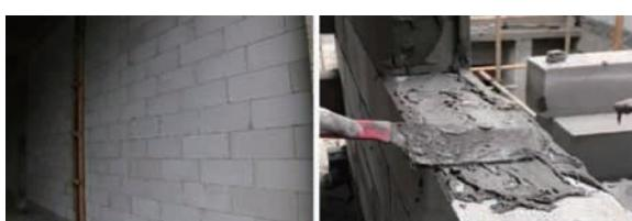
采用薄层砂浆砌筑法(薄层砂浆砌筑法是指采用蒸压加气混凝土砌块粘结砂浆砌筑蒸压加气混凝土砌块墙体的施工方法,水平灰缝厚度和竖向灰缝宽度为2mm~4mm。)进行砌筑的墙体,灰缝厚度控制在2mm~4mm范围内,采用专用砌筑粘接剂进行砌筑,水平灰缝和竖向灰缝饱满度要求达到100%。
