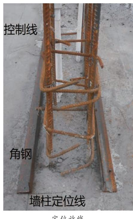
2. 角钢钻孔:在角钢上预先进行钻孔,孔径4mm,钻孔个数根据现场剪力墙长度而定。其两端部必须钻孔,距角钢端部边缘5~7cm,中间间距一般控制在60cm左右。
