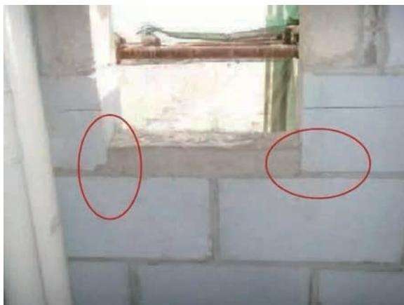
窗台混凝土压顶未伸入窗墙体两侧,后期易形成倒八字裂缝
