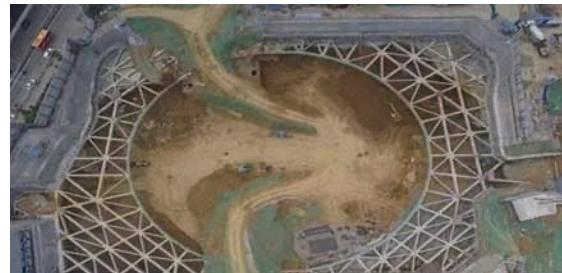
施工场地要适合拱圈布置,构造应符合圆环受力的特点,拱脚的稳定性应予足够重视,并有可靠的保证措施。
