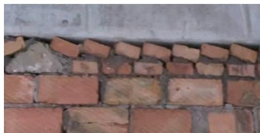
墙体顶部砌筑不符合要求,灰缝不密实
