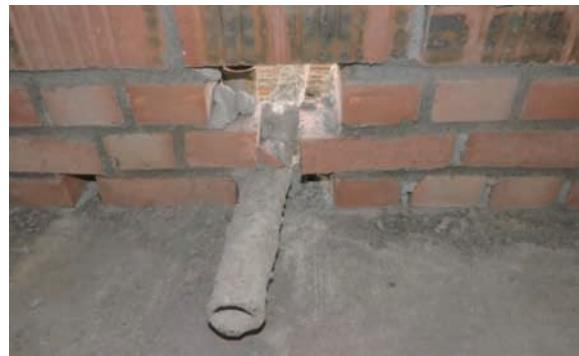
外墙脚手眼堵塞不严或封堵方法不正确导致外墙渗水
