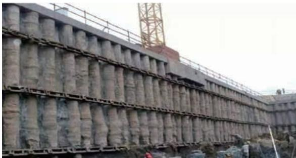
**悬臂式支护**适用于开挖深度不超过10m的黏土层,不超过8m的砂性土层,以及不超过5m的淤泥质土层。
