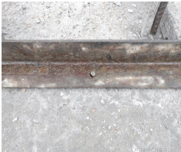
3. 根部垫脚:裁剪4cm宽橡塑薄板粘贴于现浇楼面墙柱根部,用于角钢垫脚,尤其适用于楼面根脚局部收面不平整部位。
