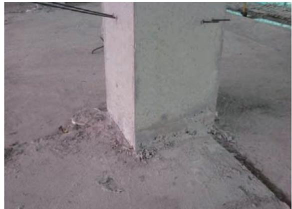
为解决墙柱根部漏浆问题，当前的工程项目普遍采用角钢体系，有效杜绝了根部漏浆、烂根和变形移位现象等质量通病：采用钢钉固定角钢，使之成为一个整体，既能保证墙、柱混凝土振捣时不外漏浆体，无烂根变形，又能确保墙柱支模定位无偏移现象；另外，如与角铁接触的混凝土楼面上口增设一条通长橡塑保温薄板，效果更佳。
