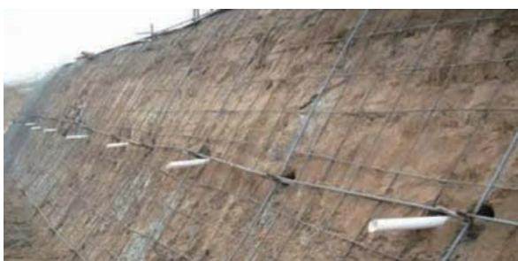
适用于地下水位以上或经人工降水后的人工填土、黏性土和弱胶结砂土,开挖深度为5~10m的基坑支护。土钉墙不适用于含水丰富的粉细砂层、砂砾卵石层、饱和软弱土层。不适用于对变形有严格要求的基坑支护。
