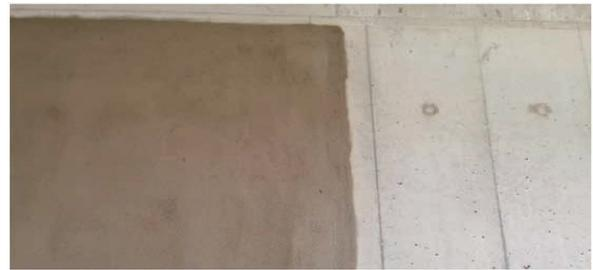
混凝土墙面免抹灰+砌体薄抹灰工艺
