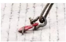
吊具安装完成后，墙板与钢丝绳的夹角须大于45度；缆风绳应放置在墙板的正面便于操作。在吊钩挂钩之前应先确认吊钩与卡环及钢丝之间连接是否牢靠。检查吊钉周围混凝土是否有开裂等质量缺陷。
