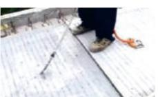
检查楼板两端支撑于墙或梁上支撑长度，以及相邻叠合板拼缝宽度。
