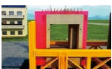
拆除对应安装位置的外防护栏杆并将拆卸的临边防护杆放至存放架内，再统一吊运。
