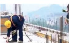
构件在安装完成之后，项目质量工程师必须对安装叠合楼板的标高及方向进行实测实量验收。
