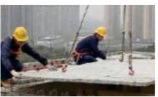
在安装吊具时，应根据构件重量、形状选择合适的钢丝绳及吊具。缆风绳应放置在叠合板正面，以便于操作。
