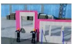
斜支撑在安装时应统一高度，根据构件长度增加中间斜支撑，斜支撑底部固定不少于2个自双螺栓，斜支撑底部螺杆伸出长度不大于250毫米。
