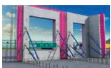
首先调节斜支撑，在调整垂直度时，应将固定在墙板上的所有斜支撑同时旋转，严禁一根往外旋转一根往内旋转，继续本段其他墙板的安装。
