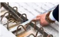
确认支撑受力均匀无松动，楼面指挥向塔吊司机发出下钩指令，取出吊钩。随后继续本段其他叠合楼板安装。
