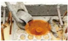
构件在吊平后，松开插销起吊，构件起吊后在离地面1米左右静停，再消除构件摆动。
