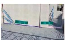
构件在安装完成后，项目质量工程师应对构件的边线、端线、垂直度、竖缝宽度进行实测实量验收。
